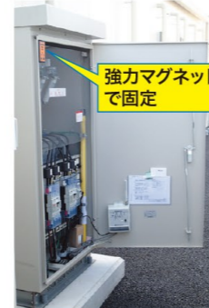
●使用例(キュービクル点検作業)
